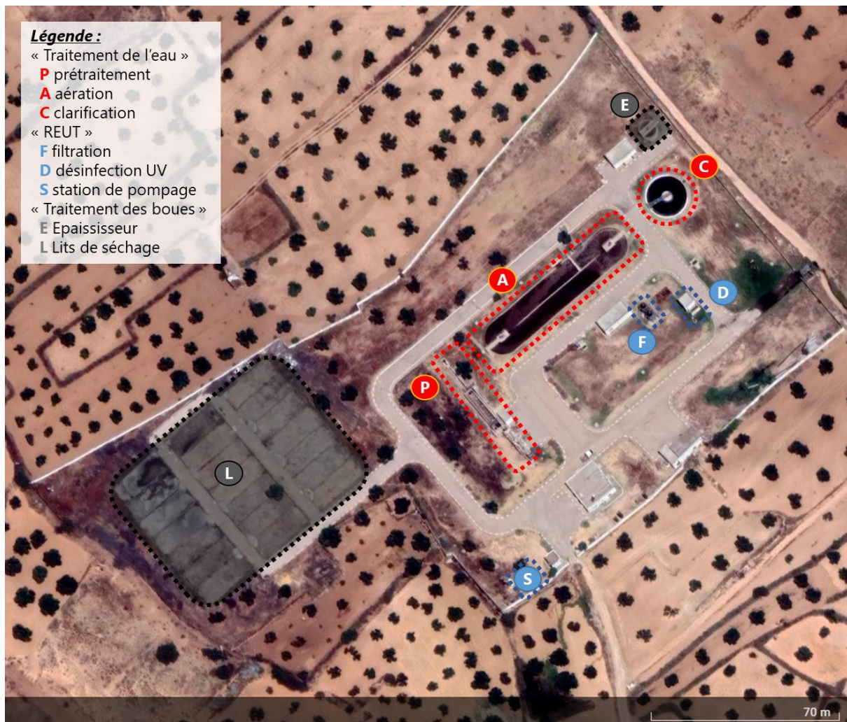
Figure 7 : Vue aérienne de la station d'épuration
