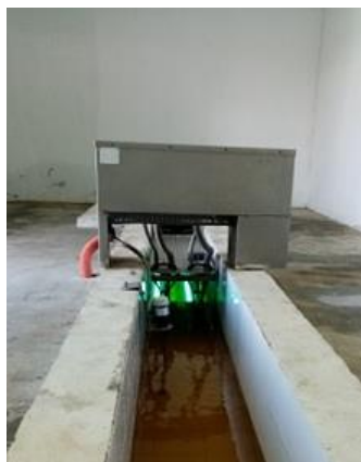
Figure 12 : Traitement UV, lampe réparée (novembre 2020)
