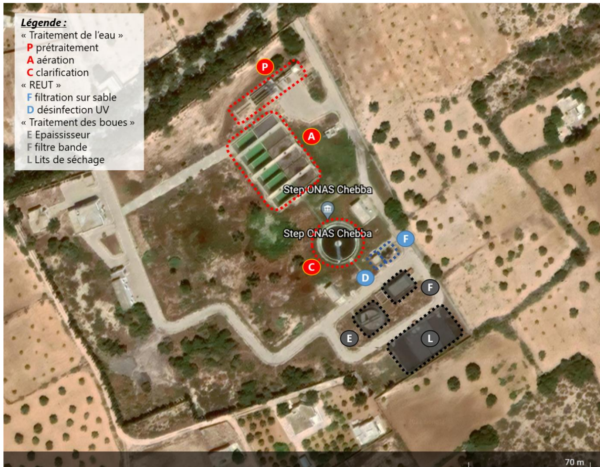
Figure 7 : Vue aérienne de la station d'épuration
