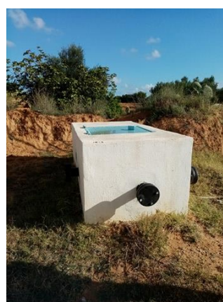
Figure 16 : Bâche de reprise et station de pompage
