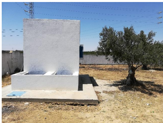
Figure 16 : Bâche de reprise et station de pompage
